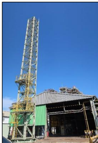
ปล่อง Pyrolysis Oven
